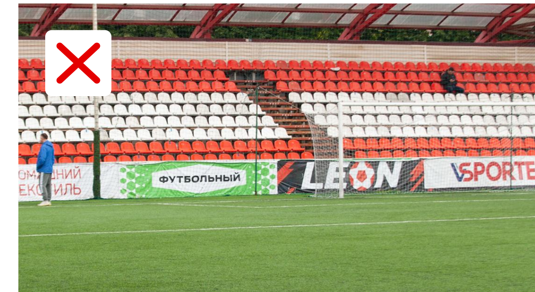
Пример некорректно закрепленных рекламных конструкций 1-й линии
